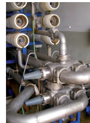
Sistema de recuperación de energía cinética en desaladora instalada en la Isla de Sal
