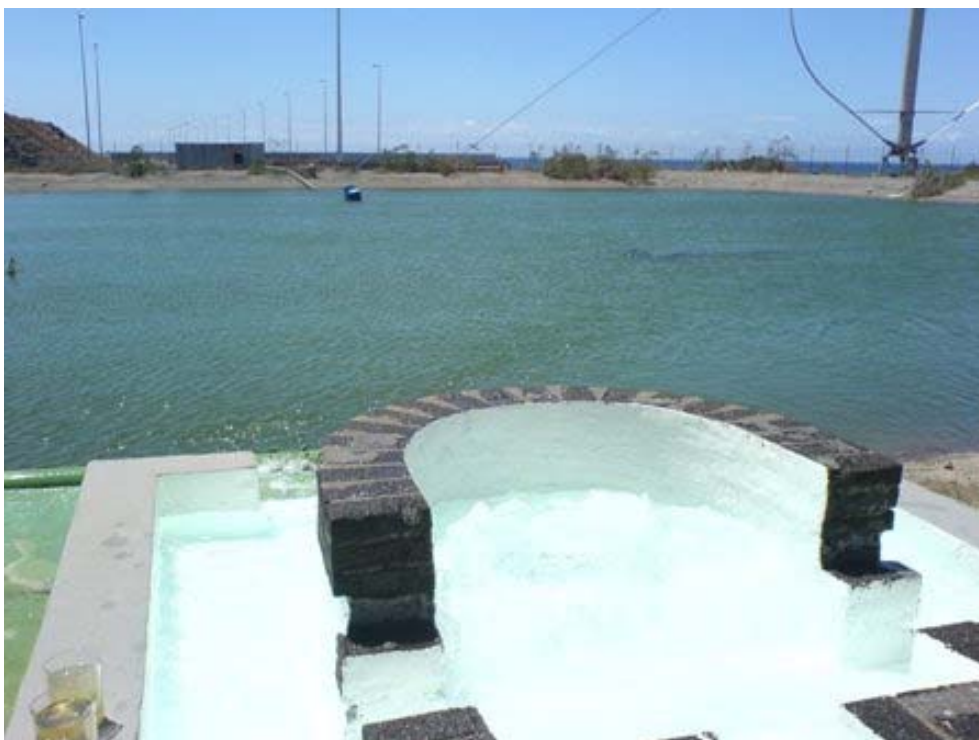
Almacenamiento producto final
