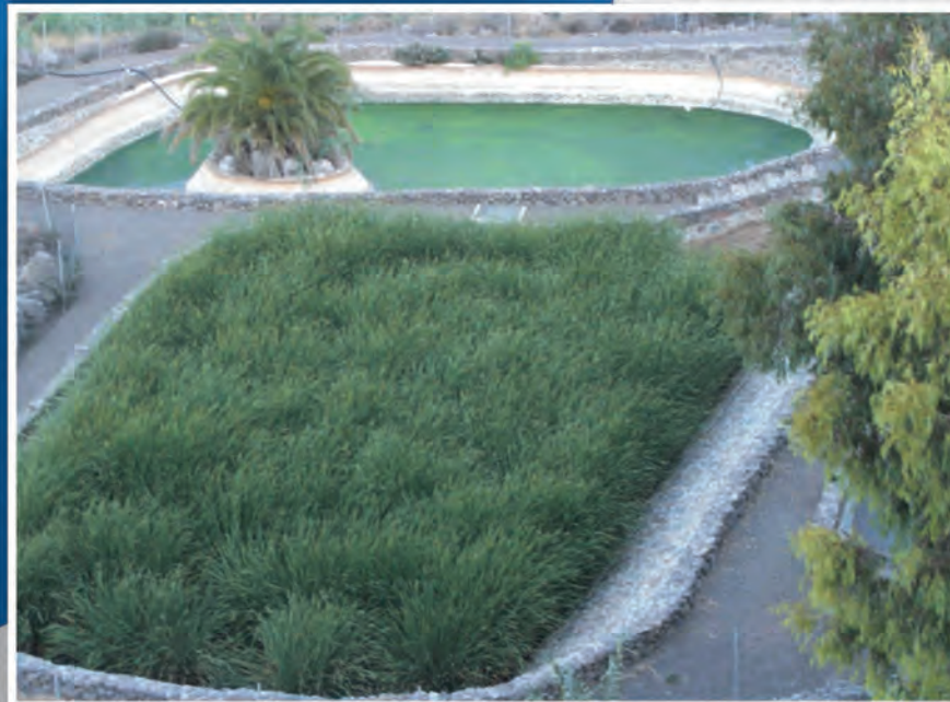
Fases finais de um Sistema de Tratamento Natural (STN) em Santa Lucía, Gran Canaria (Foto: ITC).
