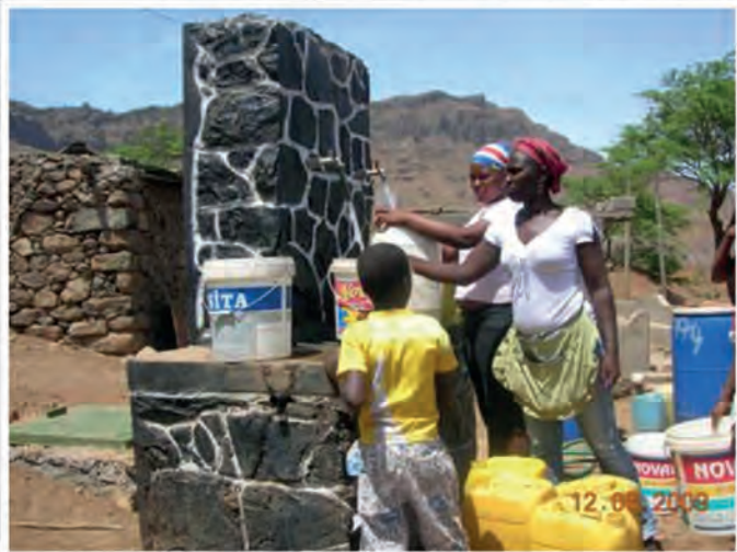
Chafariz para abastecimento de água potável (R. Ferreira, 2000).
