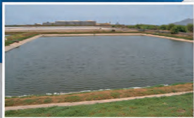
Estação de tratamento de águas residuais por lagunagem em Mindelo, em San Vicente (sistema de baixo custo energético).
