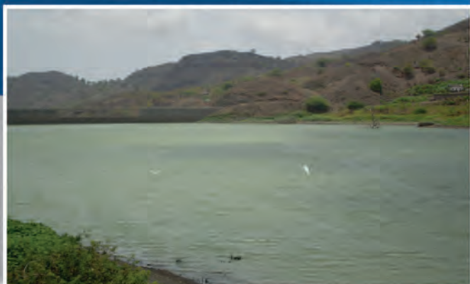
Barragem de Poilão (R. Hernández, julho 2012).
