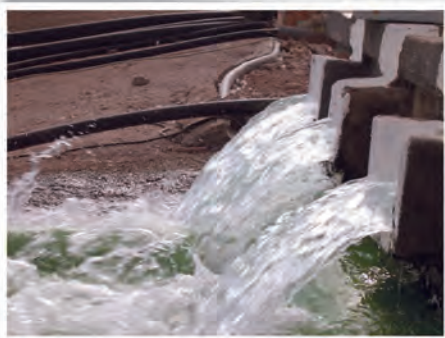
Água produto de Instalação Depuradora del Suleste.
